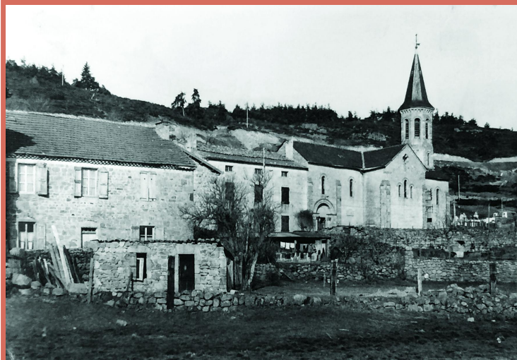
Vue sur le village de Naussac avec en arrière-plan, la route du barrage qui était en travaux à l'époque
