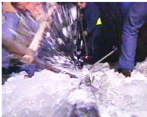
Les cheminots déglacent les rails à la pioche par grand froid (extraits des Cheminots oubliés – France 3 1996)
